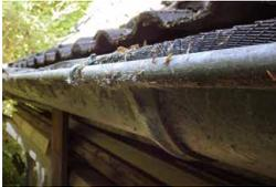
An Dachrinnen können Korrosionsschäden entstehen, aufgrund dessen Wasser unbemerkt in Wände oder Giebelkisten (Dachkästen) eindringen kann. Hausbesitzer sollten die Dachrinne regelmäßig von innen mit Schutzfarbe streichen. Das verlängert deren Lebensdauer und verhindert Folgeschäden.
