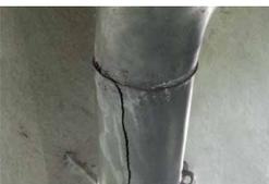
Bei Regenfallrohren können speziell an den Fallrohrbögen Löcher durch Korrosion entstehen. Das Wasser kann dann unkontrolliert an den Wänden herunterlaufen und ins Mauerwerk eintreten.
