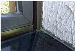
Man sollte darauf achten, dass die Anschlüsse zum Mauerwerk/zur Fassadenverkleidung, die oft mit Silikon abgedichtet sind, tatsächlich dicht sind. Hat sich das Silikon gelöst, sollte die Fuge neu abgedichtet werden. Das alte Silikon muss vorher gründlich entfernt werden, bevor man das neue Silikon (gemäß den Herstellerangaben) aufbringt.
