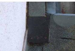
Auch hier gilt regelmäßige Kontrolle, denn Silikonfugen sind Wartungsfugen. Gerade wenn Silikon ständig der UV-Strahlung ausgesetzt ist, wird es spröde und rissig. Wenn das der Fall ist, kann Wasser leicht in die Wände eindringen.
