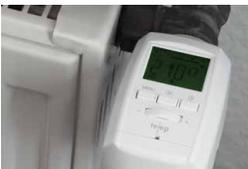
Bevor die Heizperiode beginnt, muss man folgende Regeln beachten: Den Heizkörper unbedingt entlüften. Zu viel Luft im Heizkörper verhindert, dass die Wärme vom Heizkörper optimal verteilt werden kann.
