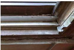
Hier gilt Ähnliches wie bei der Fensterbank, jedoch sollte zusätzlich sichergestellt werden, dass die vertikalen Anschlüsse dicht sind, da hierdurch bei starkem Regen oder Schnee sehr schnell viel Wasser eindringen kann.
