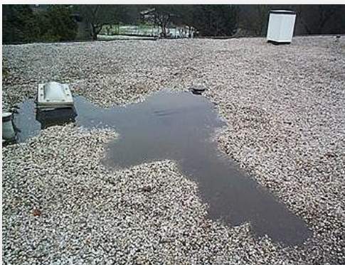
Quelle: Georg Meyer ( verstopfter Flachdach Gully und undichter Gully)
