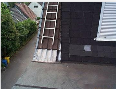
Quelle: Georg Meyer Defekter Bleianschluss an einer Dachgaube und Brandmauer)
