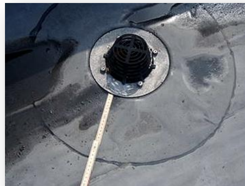
Quelle: Georg Meyer ( verstopfter Flachdach Gully und undichter Gully)
