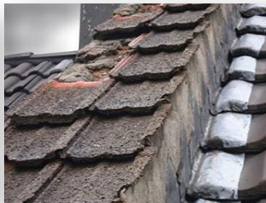
Quelle: Georg Meyer Defekter Bleianschluss an einer Dachgaube und Brandmauer)
